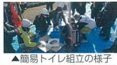
▲簡易トイレ組立の様子
