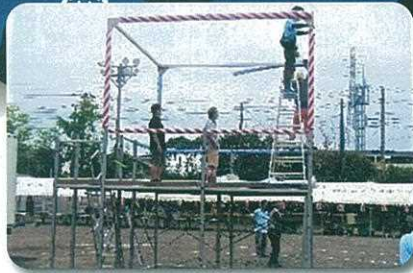
▲櫓の組立作業
